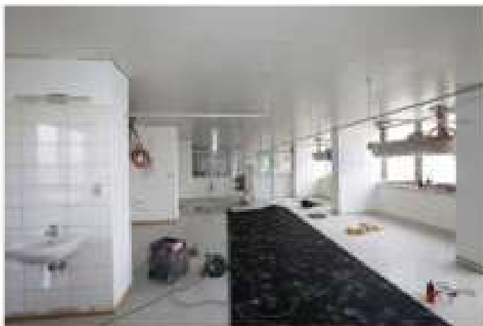
2021 zhotovený štádiu sa rekonštruuje UNLP Košice
